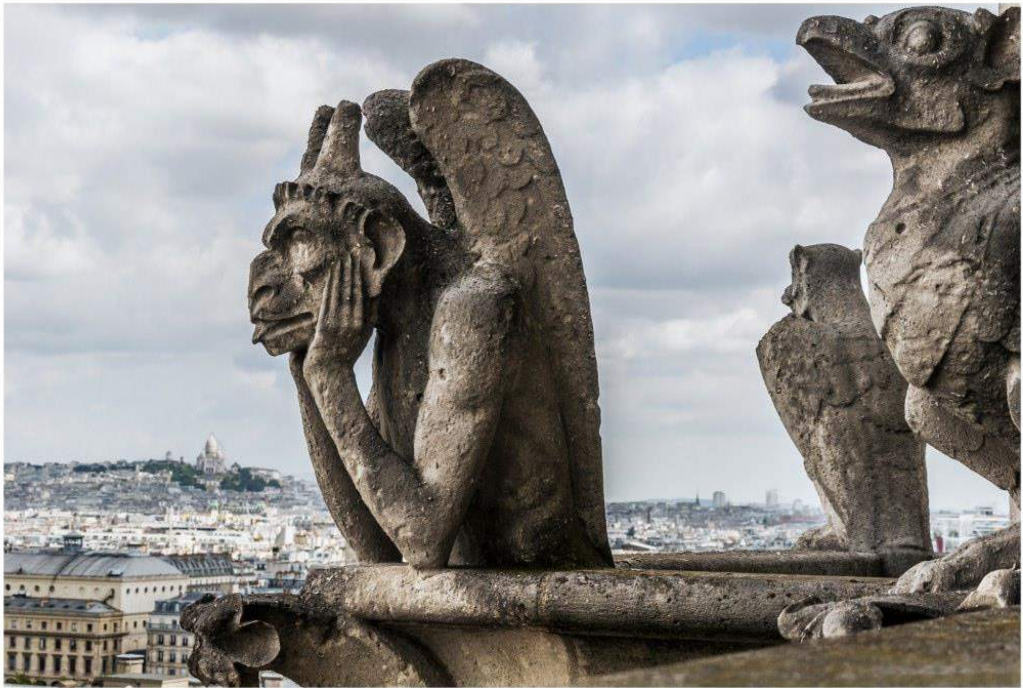
Les Gargouilles (certaines servent à évacuer l'eau de pluie des gouttières)
